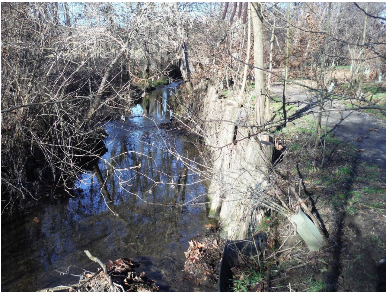
Figura 11 – Palificata esistente in sponda sinistra, vista da valle verso monte
