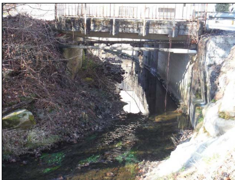
Figura 10 – Accumulo di sedimenti sotto l'attraversamento di via Turati, vista da monte
