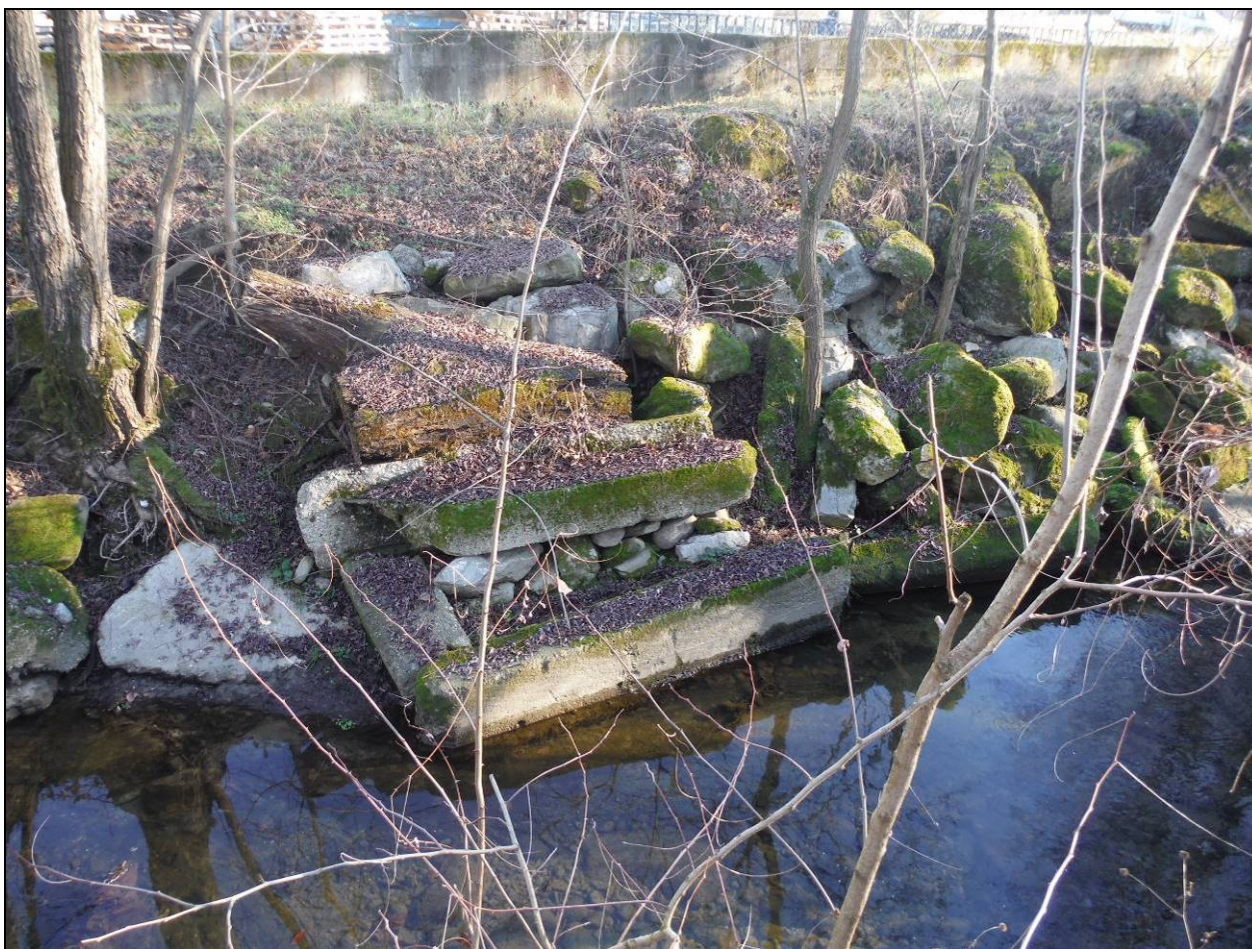
Figura 13 – Scogliera esistente in sponda destra, vista dalla sponda opposta
