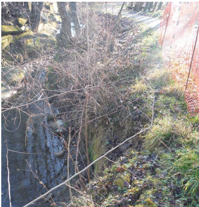
Figura 14 – Erosione spondale in sponda sinistra, vista da valle verso monte
